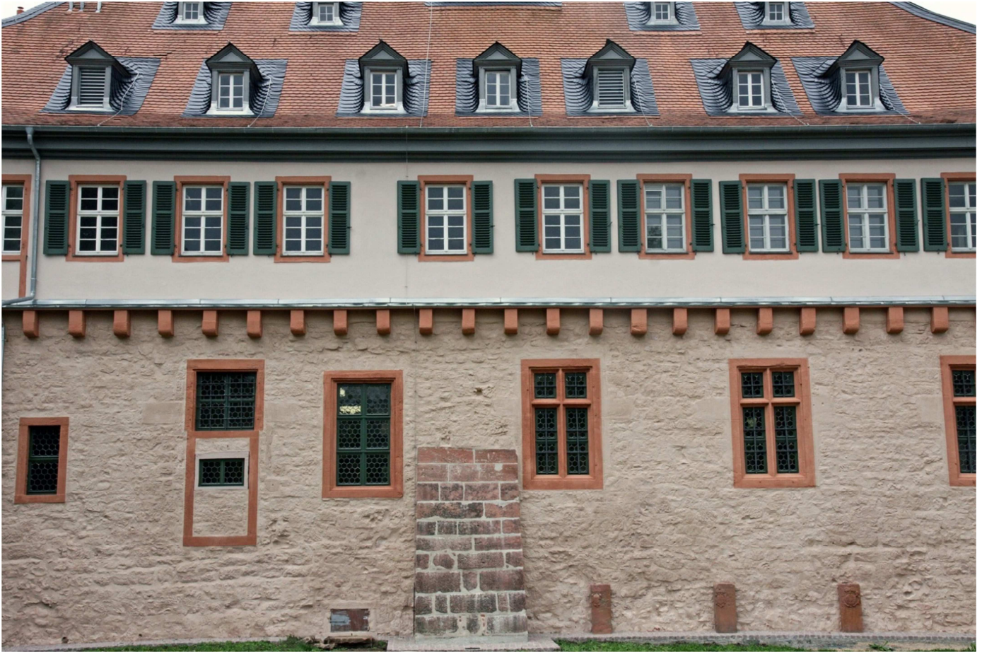
Ein Blick auf die sanierte Westseite des Pfälzer Schlosses. Das Erdgeschoss besteht aus der alten Groß-Umstädter Stadtmauer.
